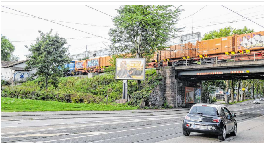
Die Brücke über die Seckenheimer Landstraße in Neustheim: Sie soll erneuert werden. Links von ihr ist eine S-Bahn-Haltestelle vorgesehen.
